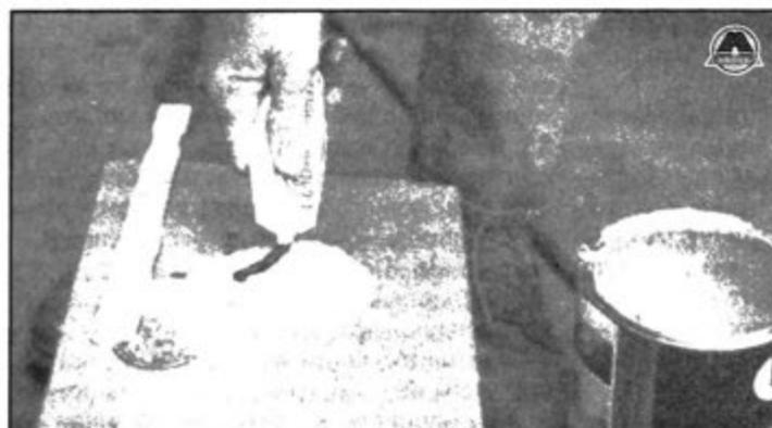
**5** Внимательно изучив сопроводительную инструкцию, приготовьте раствор шпаклевки и отвердителя. Строго соблюдайте пропорцию, иначе шпаклевка не затвердеет должным образом или затвердеет слишком быстро (до завершения шпаклевки и шлифовки поверхности)
