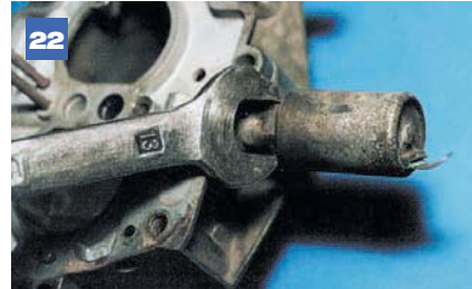
Ключом «на 13» отворачиваем электромагнитный клапан...
