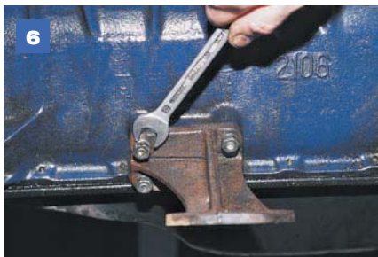
6 Ключом «на 13» отворачиваем четыре гайки крепления кронштейна передней опоры к блоку цилиндров...
