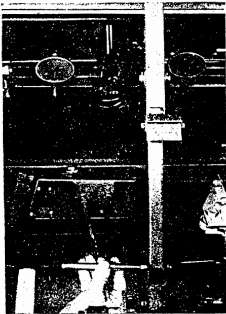
Bild Fa 7. Herausschlagen des Bolzens
