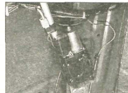
20.8 Блок антенны установлен на левой стороне багажного отделения
