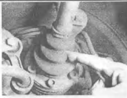
23.2 Мягко прощупайте защитные чехлы приводных валов, проверяя наличие трещин
