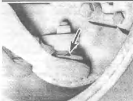
22.10 Осмотрите защитные чехлы шаровых опор на наличие разрывов (указаны стрелкой)
