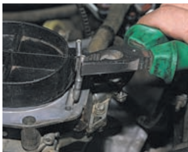
...пассатижами выворачиваем шпильку из крышки.
