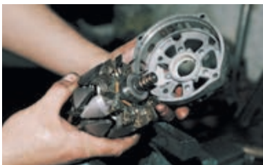
...выбиваем ротор с подшипником из задней крышки.
