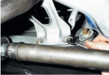
Ключом «на 13» отворачиваем два болта кронштейна крепления приемной трубы...
