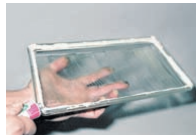
Наносим на край стекла герметик равномерным валиком.
