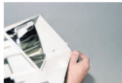
Зачищаем поверхность от старого герметика.
