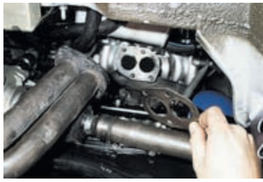
Снимаем приемную трубу и ее прокладку.
