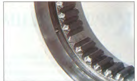
Фото 5. Состояние входных кромок шлицев скользящей муфты у самовыключающейся передачи.
