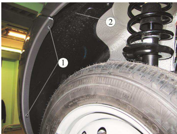
Рисунок 13-5 – Щиток переднего крыла левый:
