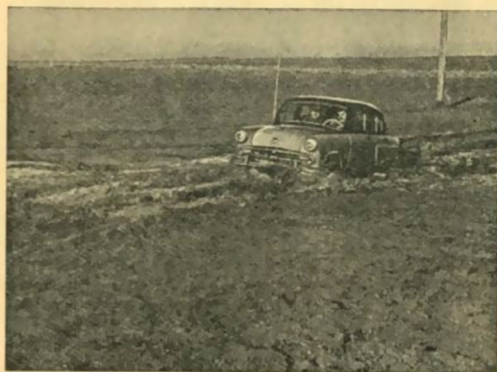
Рис. 4. Движение автомобиля по размытому участку дороги с глубокой колеей
