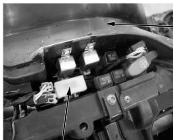
Коробка с предохранителями
