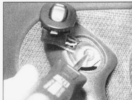
12.4. Odkręcanie wkrętu mocującego wewnętrzne pokrycie drzwi po wyjęciu wyłącznika mechanizmu elektrycznego sterowania szybą
