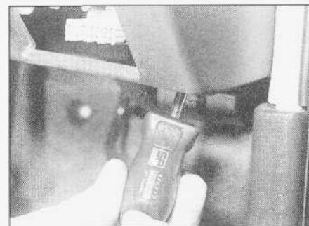
30.6a. Wykręcanie wkrętu pod skrzynką bezpieczników...
